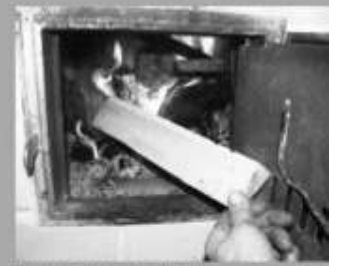
Размер дров должен соответствовать размерам топливника
